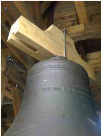
In Siethen werden zur Zeit neue, gerade Joche aus Eichenholz montiert, wie es später auch in Ahrendorf geschehen soll.
